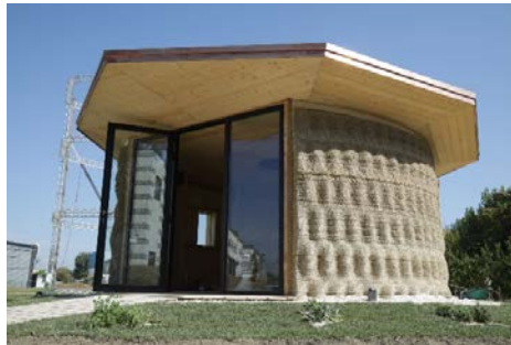
Рис.1. 3D Друк будівлі фірмою WASP.
